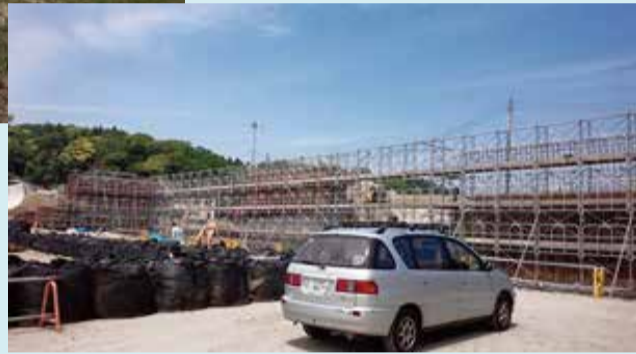
↑建設中の防潮堤 @小浜
