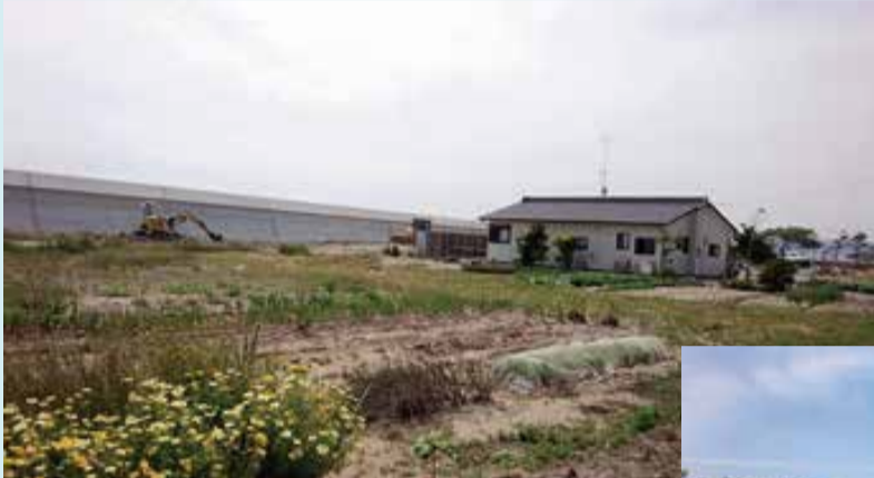
←一部完成した防潮堤
